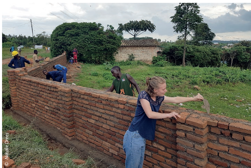
Die Freiwillige Natalie Drees hilft beim Bau einer Mauer bei einem Praktikumsprojekt der St. Peter Secondary School in der Diocese of Shyogwe, Ruanda.
